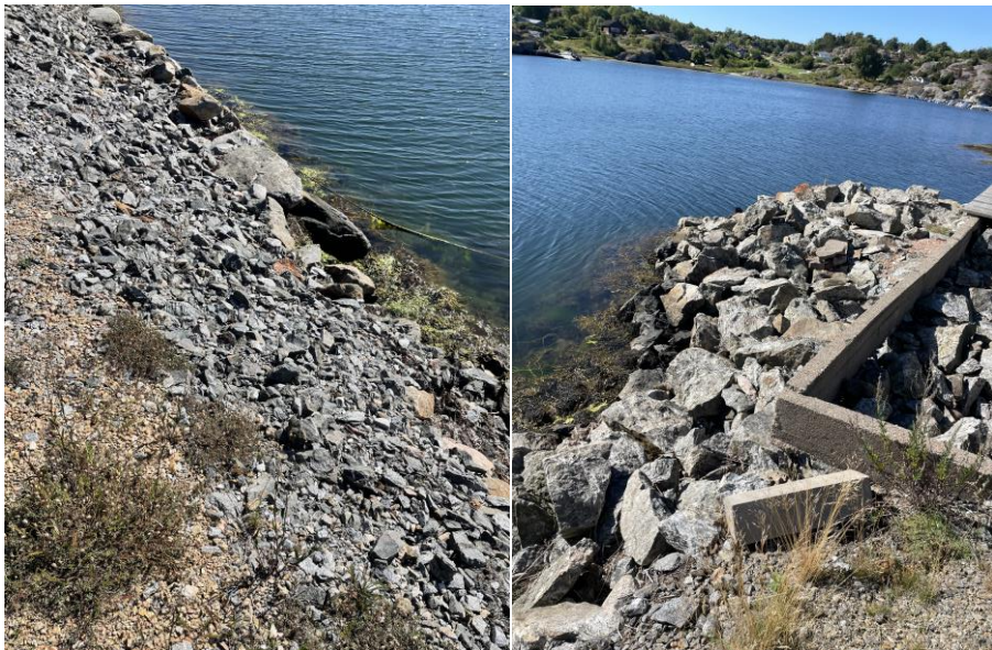
Figur 12 och 13. Sprängsten och bergkross kunde noteras vid de delar av fastigheten som vetter mot havet
