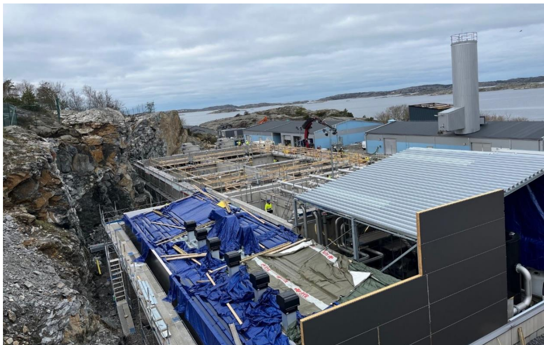
Om- och utbyggnad av reningsverket i Ellös
