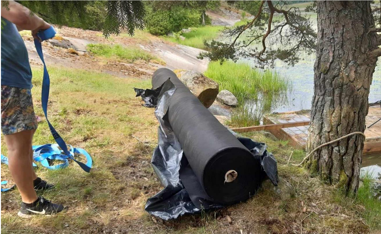
Figur 14. Rullen med markduk har transporterats ut med flotten och packas upp för vidare utplacering, 28 juni 2022. Foto: Kristian Littke
