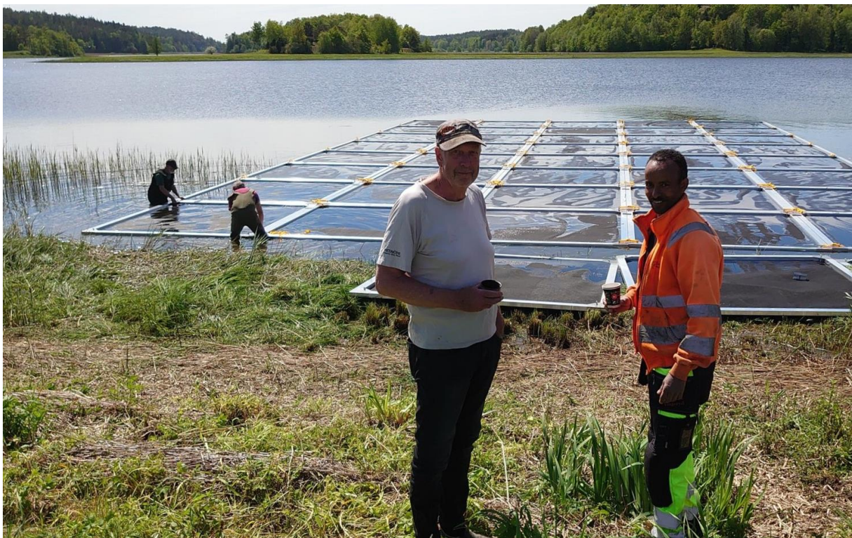
Figur 7. Hopsättning av aluminiumramarna i norra delen av sjön med hjälp av personal från Tingsryds kommun, 1 juni 2021. Foto: Kristian Littke
