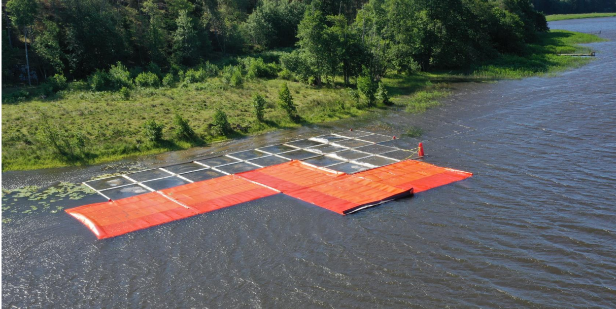
Figur 20. Ett mindre bestånd sjögull på ca 200 kvadratmeter fanns på östra sidan Andenäs. Detta upptäcktes under 2022 och bekämpningen startade sommaren 2023. På bilden syns fem av de nya flytdukar som vi testat under 2023 som kompletterar ramarna. Längst in mot stranden finns en remsa markduk, 7 juli 2023. Foto: Kristian Littke
